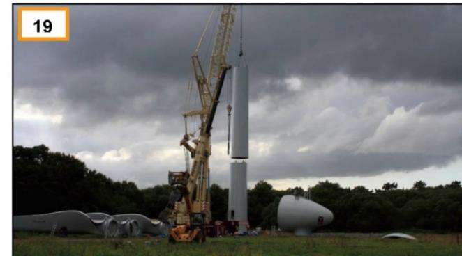
19 Assemblage d'une section de mât
