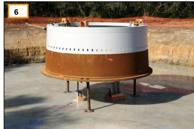
6 Disposition du tube fondation sur le béton de propreté
