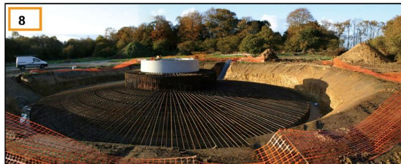
8 Ferrailage de l'éolienne terminé
