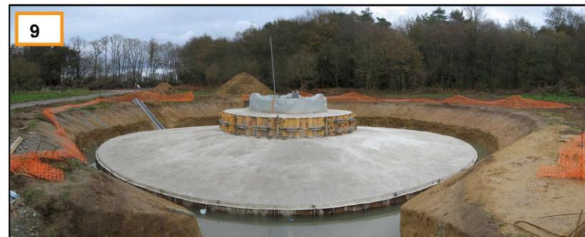
9 Coulage du béton de l'éolienne terminé
