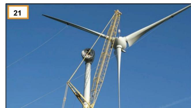
21 Assemblage du rotor sur la génératrice
